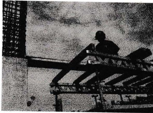
Gambar 3. Menentukan as balok pada kolom
