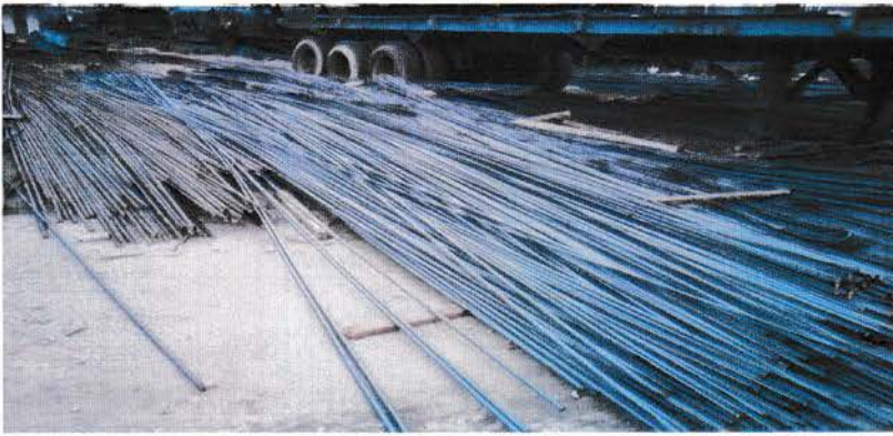
Gambar Besi Tulangan
