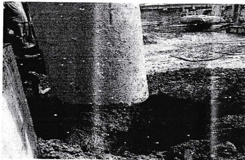
Gambar. Pembuatan Bekisting
