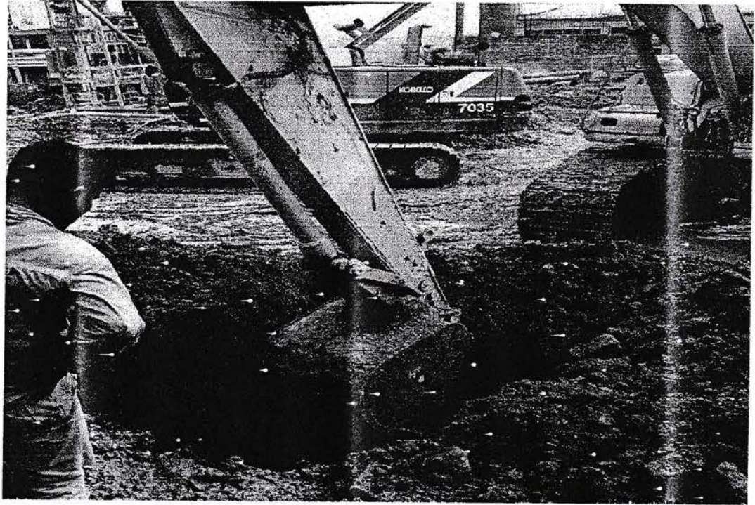
Gambar. Penggalian Lubang Pondasi
