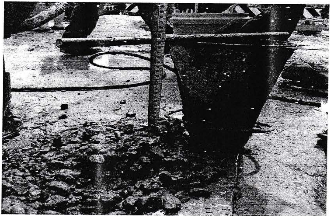
Gambar. Pengujian Beton
