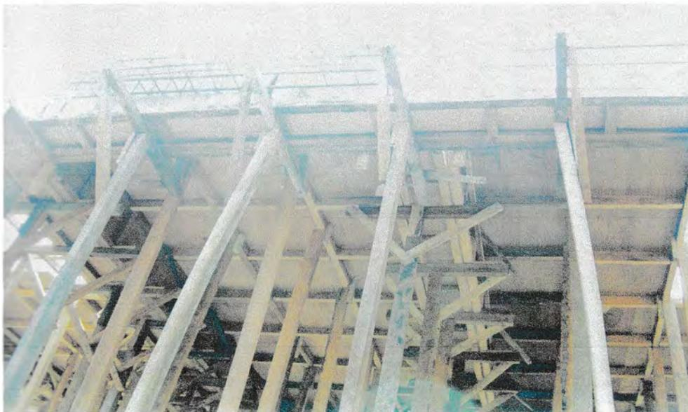
Gambar : Pemasangan Bekisting
