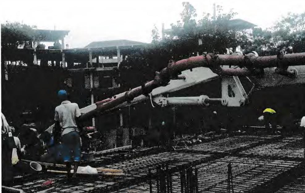
**Gambar : Pengecoran Menggunakan Pompa Concrete**
