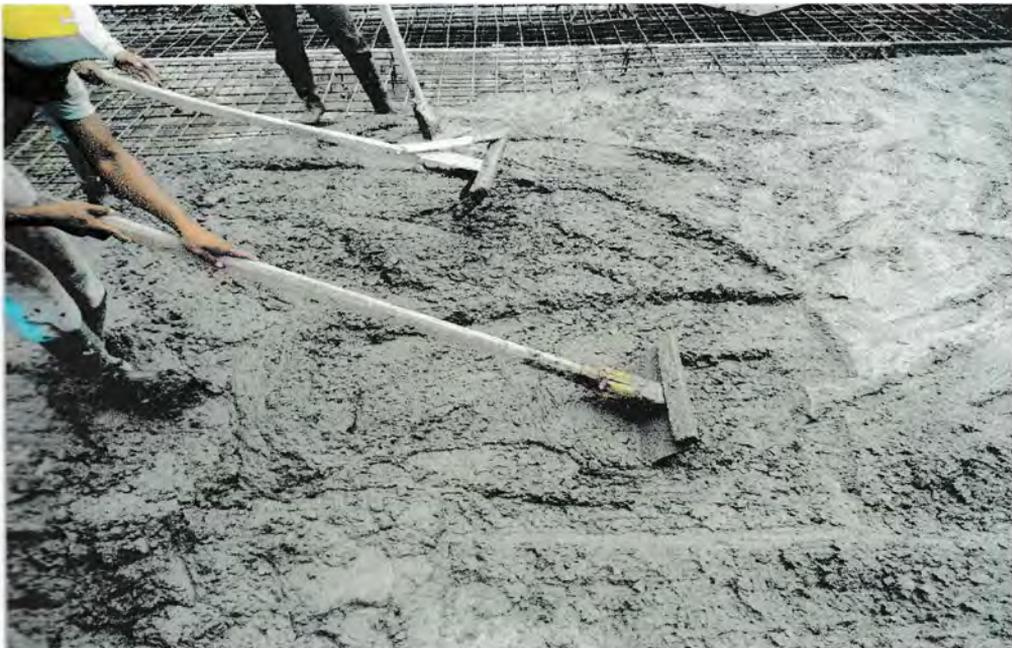
Gambar : Pengecoran Lantai
