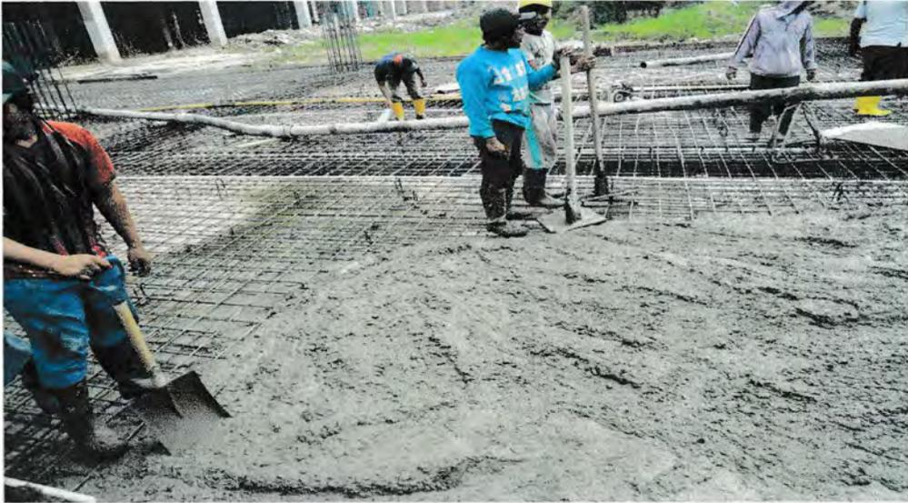
Gambar : Pengecoran Lantai
