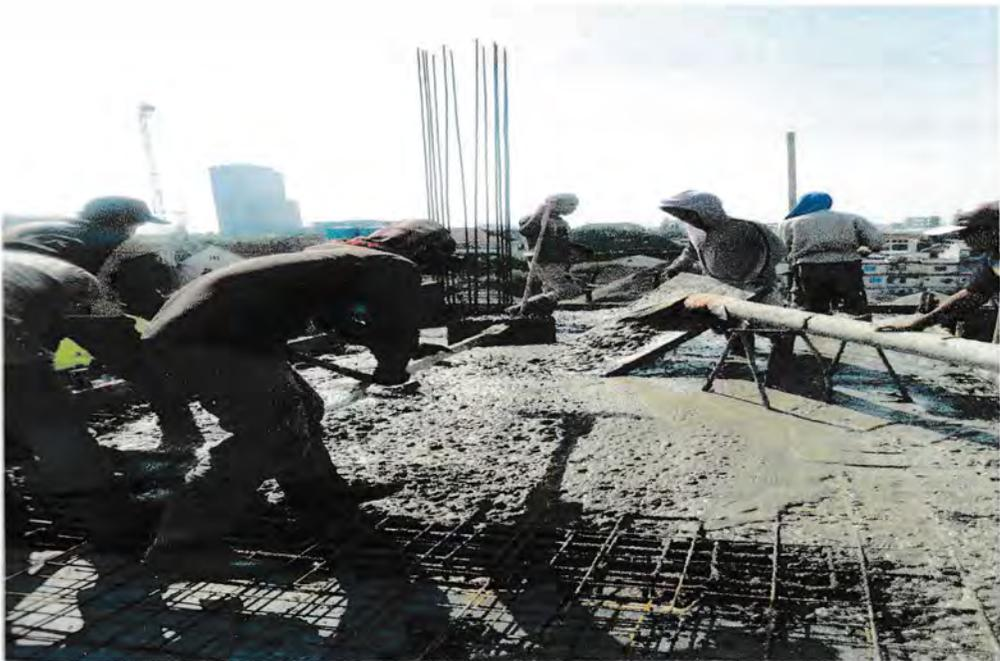
Gambar : Pengecoran lantai
