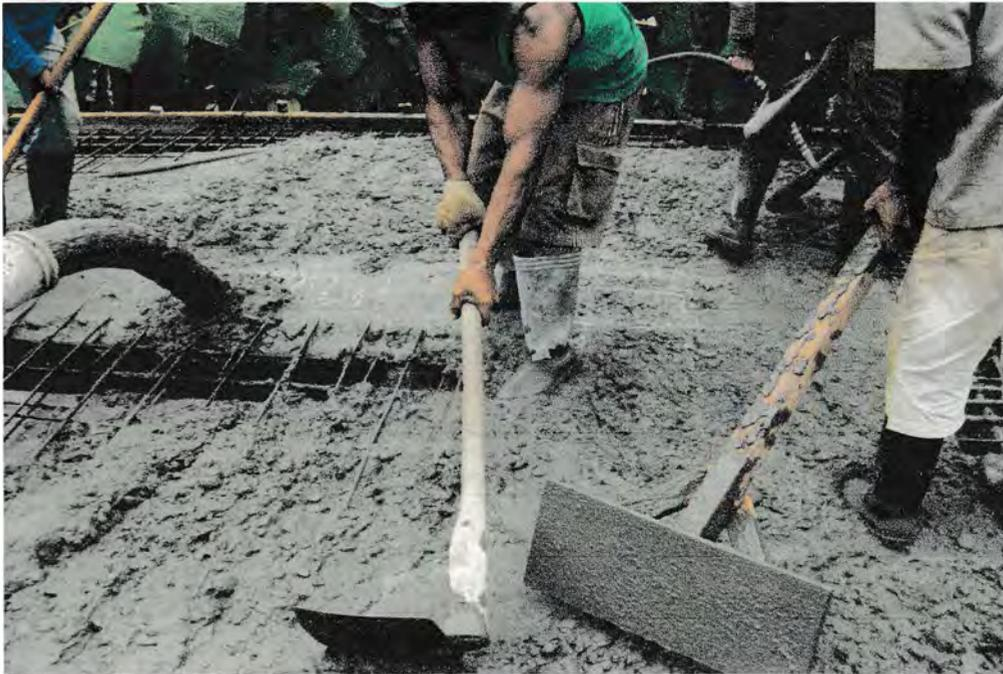
**Gambar : Pengecoran Pada Lantai**
