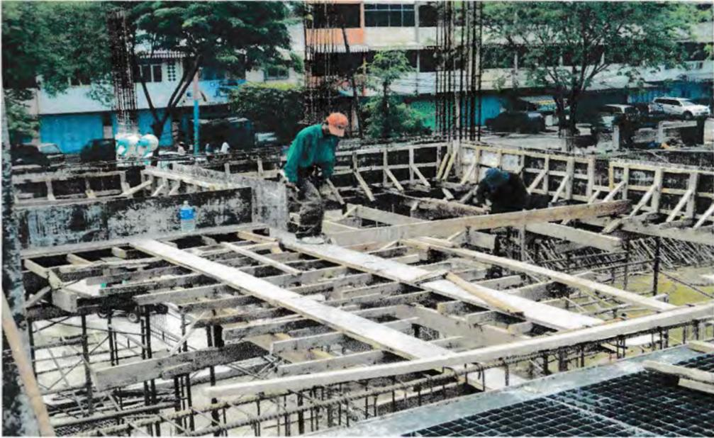
Gambar : Pemasangan Bekisting
