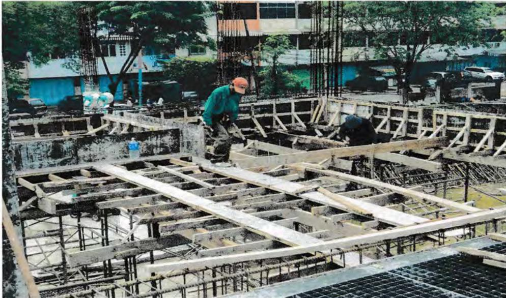
Gambar : Pemasangan Bekisting
