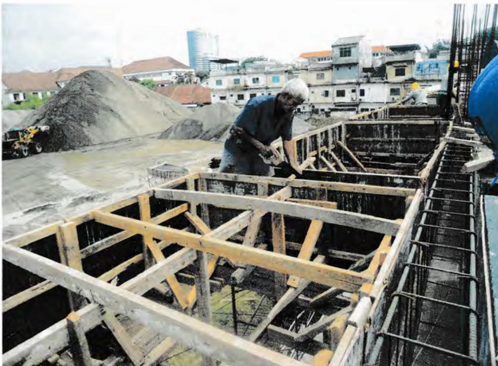
Gambar :Pemasangan Bekisting
