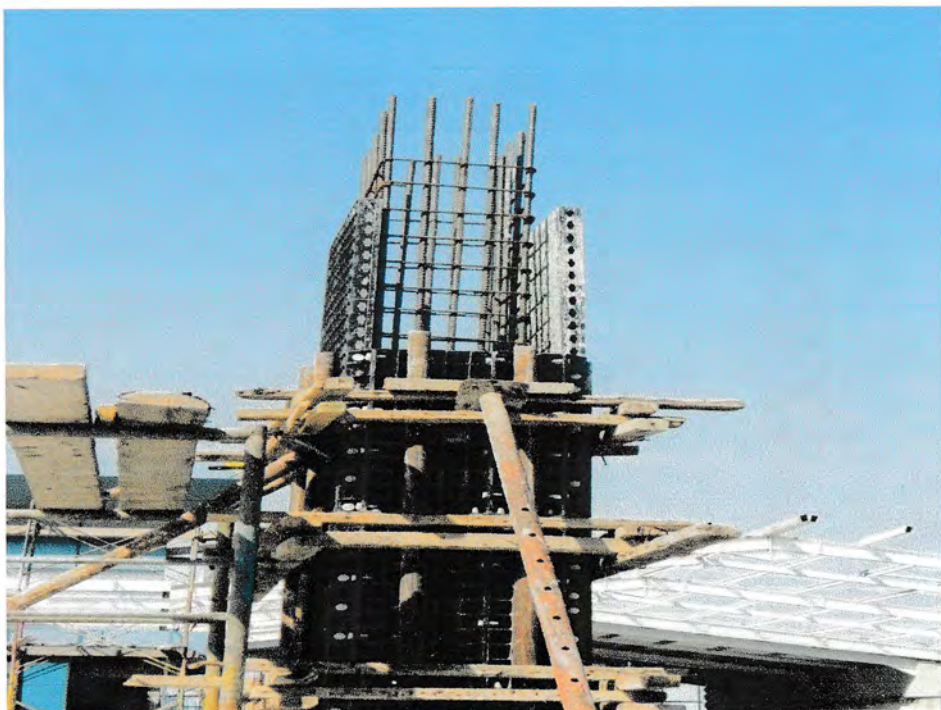
Gambar : begisting pada kolom
