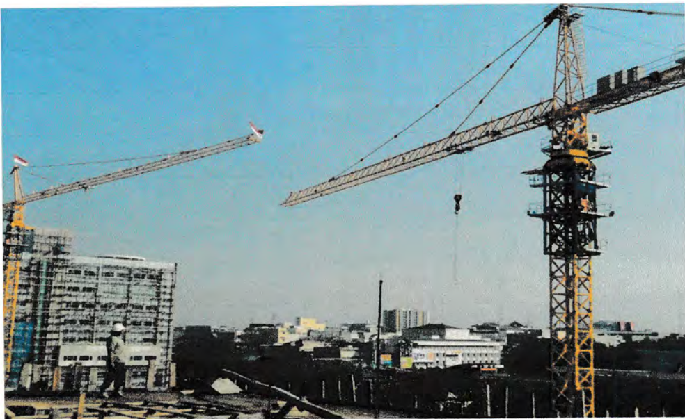
Gambar : Pengecoran menggunakan Tower Crane
