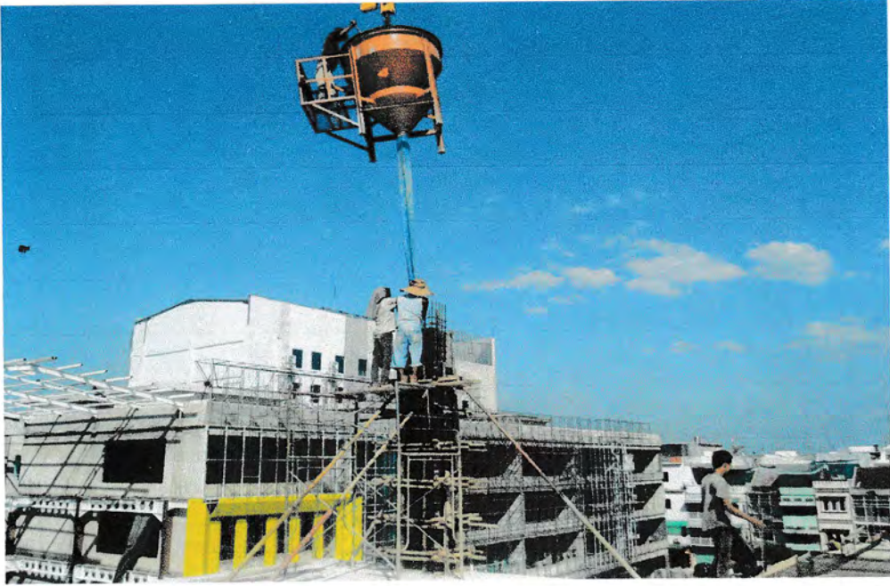
Gambar : Pengecoran pada kolom
