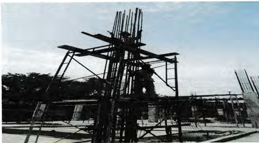
Gambar : Pekerjaan pembesian pada kolom
