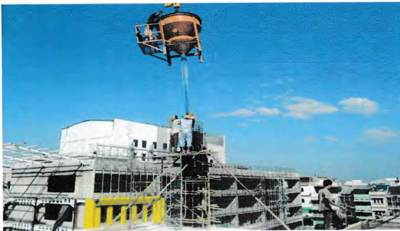
Gambar : Pengecoran pada kolom
