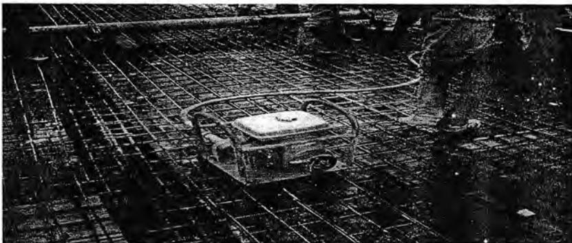
**Gambar 2.3 Mesin Vibrator**
