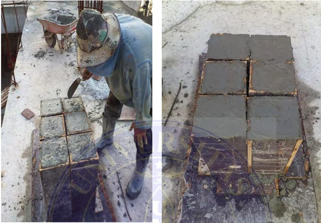
gambar 5. Perataan campuran beton
