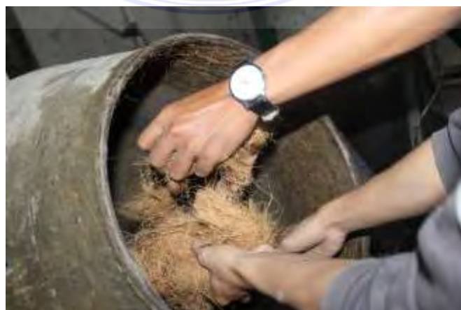
Gambar 06 Pencampuran sabut kelapa sebagai bahan tambah
